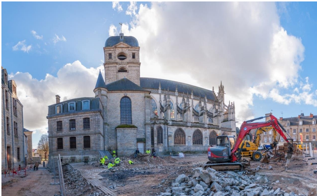
Le réaménagement de la place de la Magdeleine
